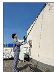
ispezione del tetto
