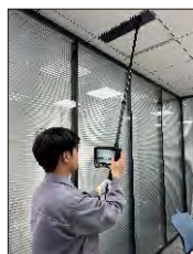
ispezione dei condotti a soffitto
